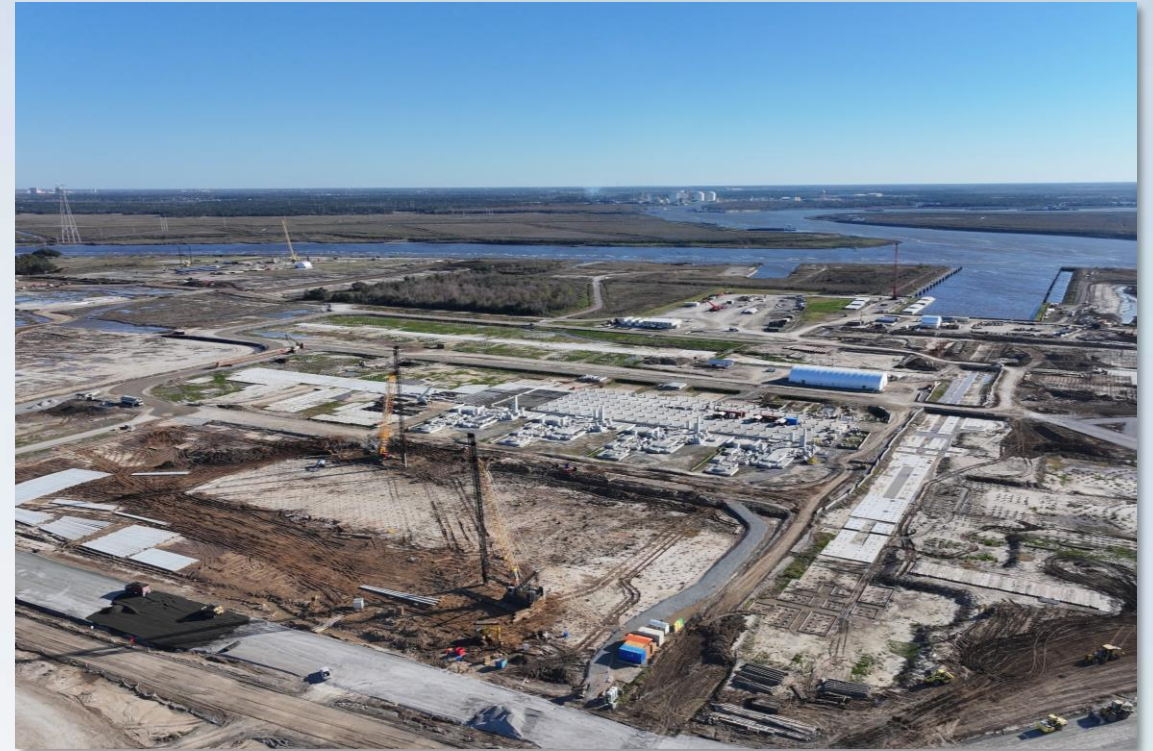
Woodside Louisiana LNG site
